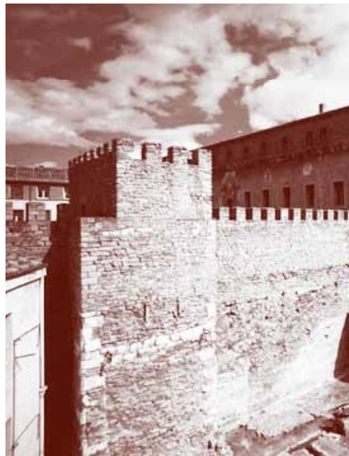
Zona del Palacio Escoriaza-Esquível durante la excavación (Foto Quintas/GPAC).
