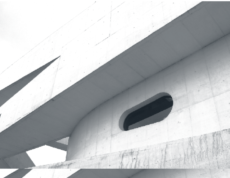
Detalle exterior de las circulaciones.
