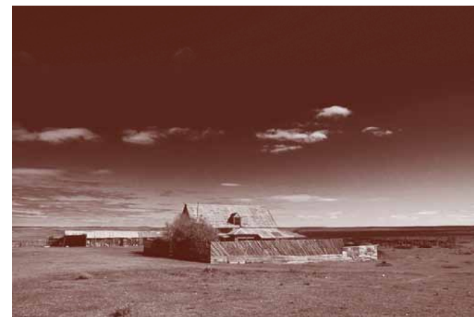
Figura 2: Casa de administración de la estancia Gente Grande. Fotografía: N. Piwonka, 2003.
