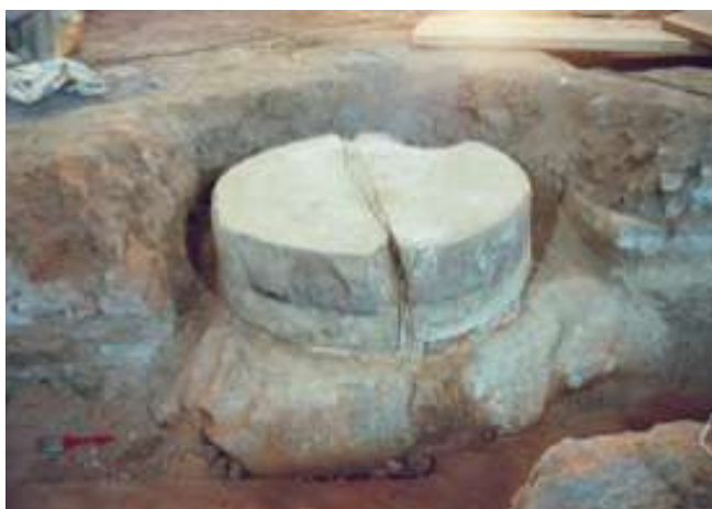
Figura 5. Base de columna de la arquería oriente de la antigua catedral descubierta durante las labores de restauración de la parroquia del Sagrario dirigidas por Amaya Irarrázaval (2000-2004). Fuente: Archivo Amaya Irarrázaval.
